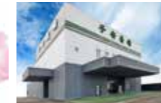
セレモニーホール 子安斎場 大垣市安井町6-17
