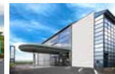
セレモニーホール ルネス美濃 美濃市1328-1
